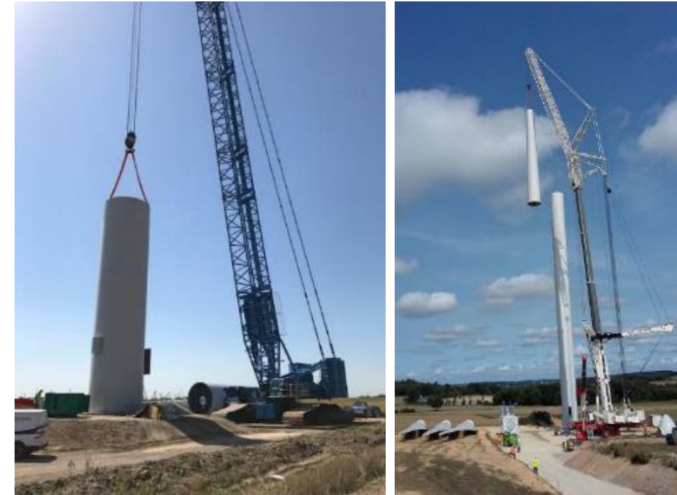
Figure 24 : Montage du mât (Elicio)
