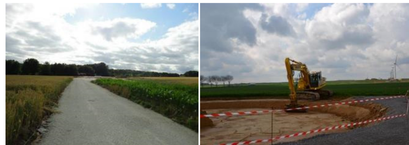
Figure 19 : Travaux pour la réalisation de chemins d'accès et de creusement des fondations (Elicio)
