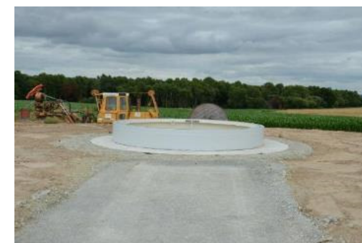
Figure 21 : Fondation d'une éolienne
