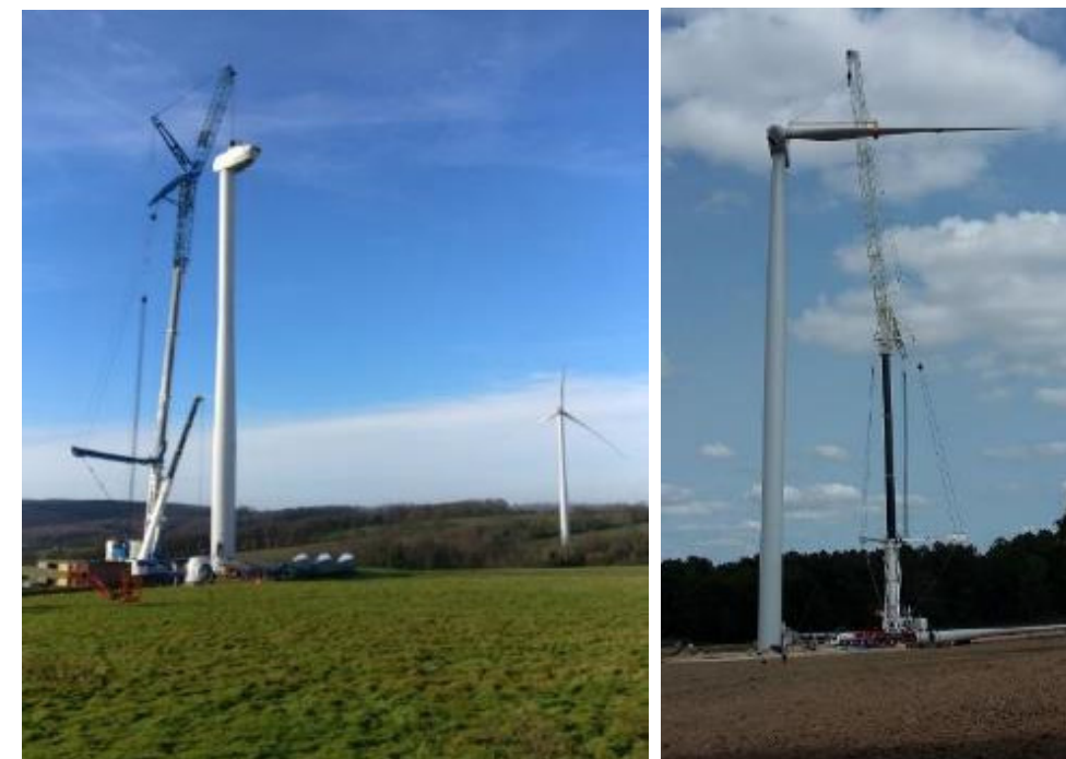
Figure 25 : Montage de la nacelle et des pales (Elicio)
